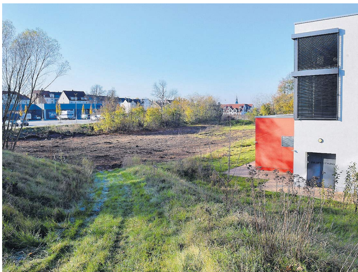
Auf der Freifläche zwischen dem Aldi-Parkplatz und dem Sportforum in Frankenberg entstehen bis zum Jahr 2022 ein neuer Kunstrasenplatz mit Flutlicht sowie ein Sozialgebäude. FOTO: FALK BERNHARDT
